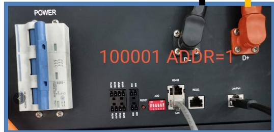
Ciascun BMS sarà connesso tramite cavi di potenza (+ e -) ai due ingressi dell'inverter, in particolare modo fare attenzione a collegare:
