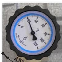
Per il riempimento e per lo svuotamento del circuito, escludere la VNR ruotando la manopola con termometro blu di 45° in senso orario, partendo dalla posizione di completa apertura (vedi figura a lato).
