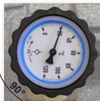
Per interventi di manutenzione, chiudere completamente la valvola a sfera ruotando la manopola di 90° in senso orario.
