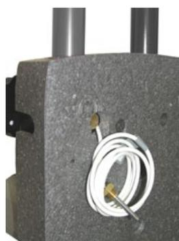
5. - Alloggiare il cavo della sonda di mandata nell'apposito passaggio al centro dell'isolamento, al fine di farlo fuoriuscire dal foro posteriore in corrispondenza della valvola a sfera a tre vie (ramo di mandata).
