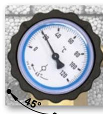
Per lo svuotamento del circuito, escludere la VNR ruotando la manopola con termometro blu di 45° in senso orario, partendo dalla posizione di completa apertura (vedi figura a lato).
