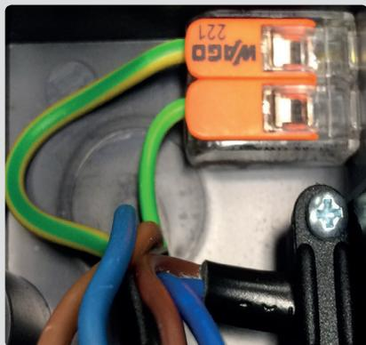
3. Aprire la centralina come Fig. C.1.1), inserire i cavi ed installare le fascette di rinforzo.
