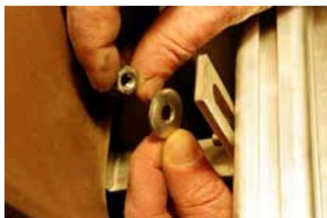
Inserire le viti con testa a martello nell'asola e fissare con dadi e rondella.
