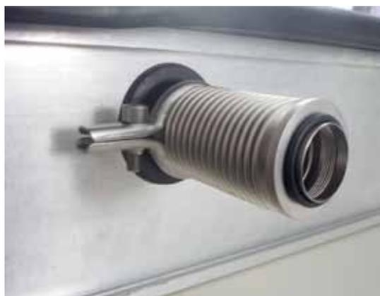
Fissare manualmente la vite sul morsetto di chiusura. L'uso di avvitatori elettrici o simili può danneggiare la filettatura. Stringere il morsetto fino a che i due lembi combaciano completamente.
