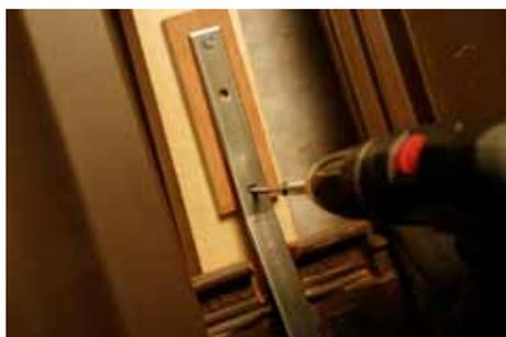
Fissare la staffa con un supporto di misura 50 x 150 x 5 mm e due viti 5 x 60 mm.
