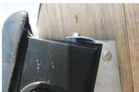
Se i supporti vengono montati a livello con i collettori più esterni, sarà necessario metterli in sicurezza con vite e dado. Montare la vite sul profilo superiore del supporto nei fori previsti.
