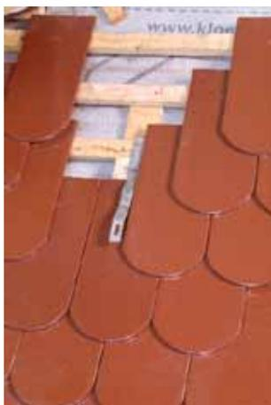
Se il campo solare viene montato in regioni con alto carico di neve oltre i 2 kN/m<sup>2</sup>, è necessario fissare le staffe nello spazio intorno al travicello.
