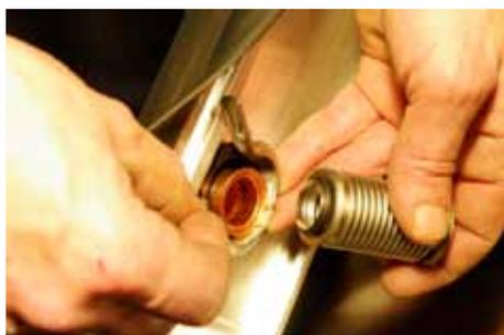
Prima di montare i collettori successivi, è necessario montare il compensatore di dilatazione sulla flangia in rame già inserita.
