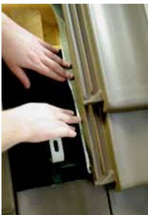
Montare la guaina di montaggio superiore e infilare lateralmente. Le viti della staffa devono essere coperte. Assicurarsi che la guaina non scivoli.
