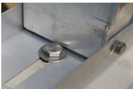
Inserire infine il triangolo di appoggio sullo zoccolo in calcestruzzo e fissarlo con le viti M10. Tutti gli altri triangoli devono essere posizionati seguendo lo stesso orientamento.
