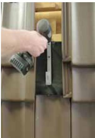
Posizionare la prima guaina di montaggio in modo da coprire il sottotegola. Fare attenzione che la guaina di montaggio sia infilata sotto la tegola accanto.
