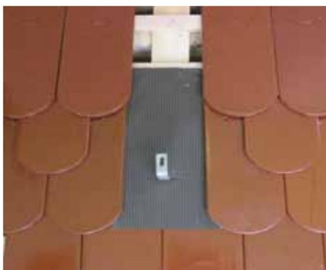
Montaggio della lamina di piombo superiore: anche questa va infilata lateralmente sotto le tegole.
