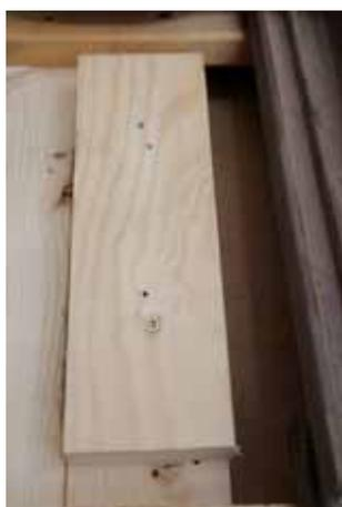
Montare uno spessore in legno di misura 80 x 270 x 30 mm e fissarlo con due viti 5 x 60mm.
