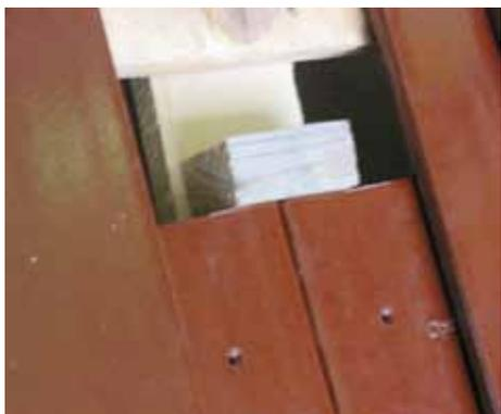
Montare lo spessore in legno di misura 80 x 50 x 45 mm con due viti 5 x 60 mm.
