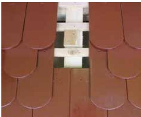
Fissare un listello in legno di misura 24 x 80 x 600 mm con due viti 4 x 50 mm.
