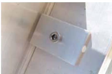
Montare sul triangolo successivo la piastra di fissaggio "doppia" in corrispondenza dei fori lunghi in alto e in basso. Il fissaggio definitivo deve avvenire dopo aver montato il collettore successivo.
