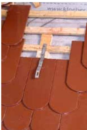
Fissare un listello di legno di misura 24 x 80 x 600 mm con due viti 4 x 50 mm.
