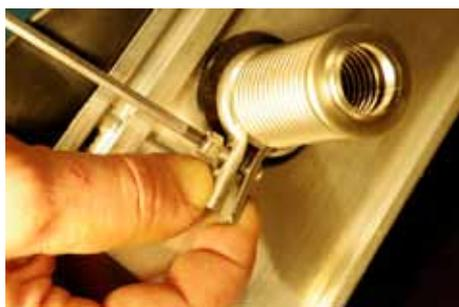
Fissare il compensatore di dilatazione in un lato con il morsetto.
