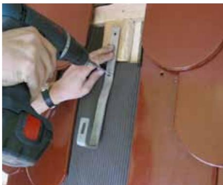
Fissare la staffa con due viti 5 x 60 mm.
