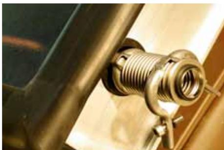
Compensatore di dilatazione montato con guarnizione e morsetto. Montare il compensatore in alto e in basso come nell'immagine.
