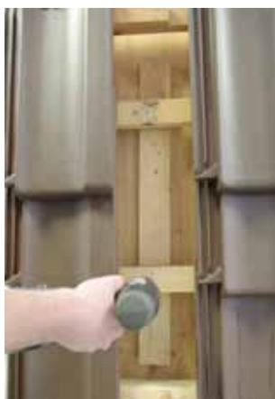
Fissare un listello di legno di misure 24 x 80 x 600 mm con due viti 5 x 60 mm.
