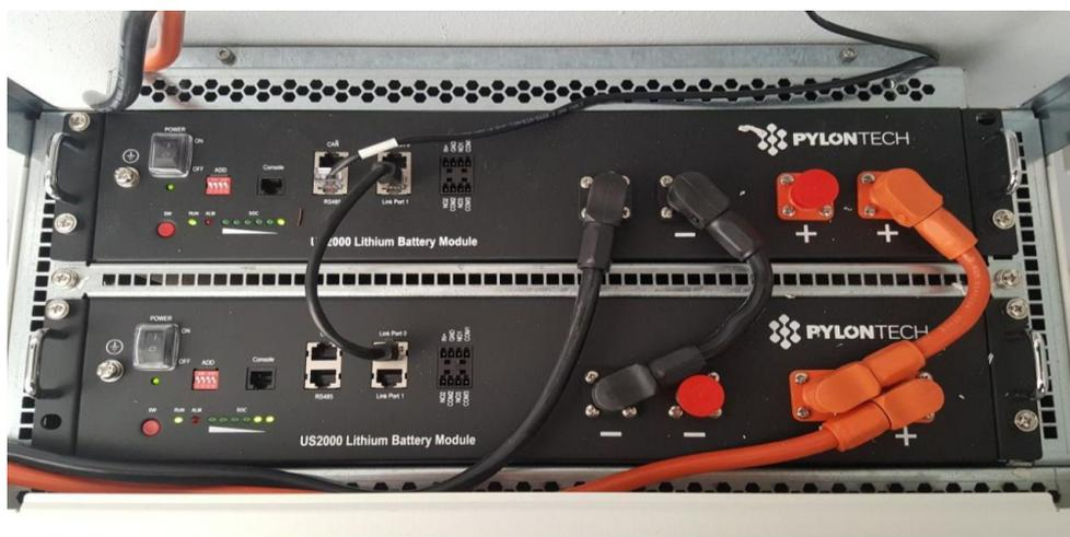
**Figura 4: Vista superiore di due batterie installate all'interno dello Storage Box**
